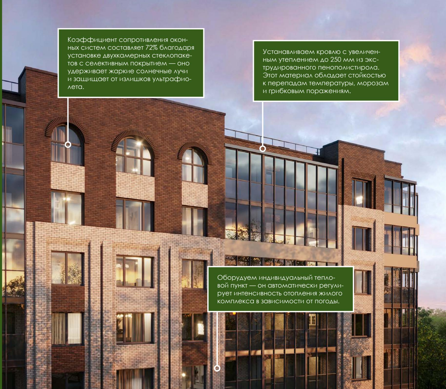
Коэффициент сопротивления оконных систем составляет 72% благодаря установке двухкамерных стеклопакетов с селективным покрытием — оно удерживает жаркие солнечные лучи и защищает от излишков ультрафиолета.
