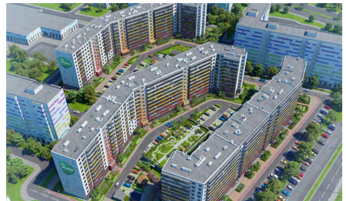
Вид на две очереди жилого комплекса «All Inclusive»
