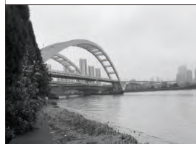
мониторинг деформаций мостов и тоннелей
