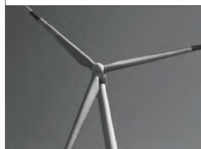
проверка деформации лопастей ветра
