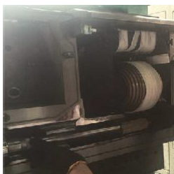
Трансформатор напряжения
