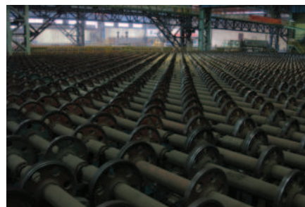
Крупный холодильник для листовой стали. Опору каждого колеса обеспечивают четыре высокотемпературных подшипника.
