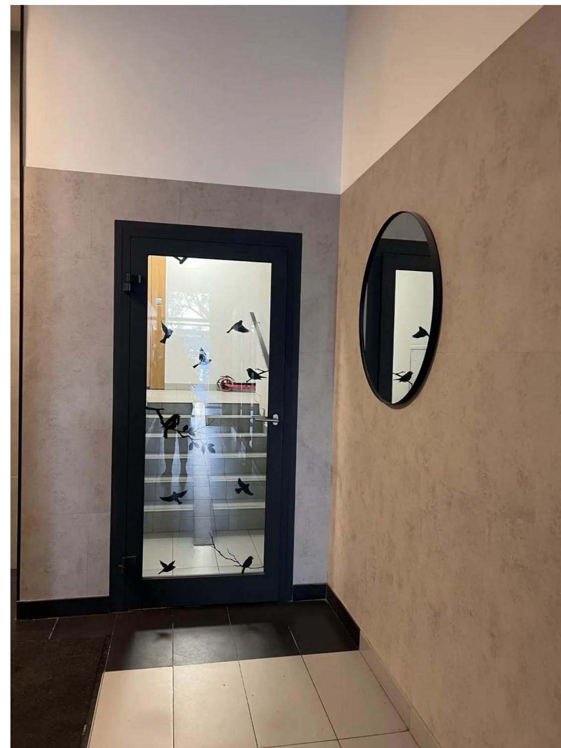
Фото 3. Ремонт первого этажа подъезда с использованием ПВХ-плитки (ул. Большевисткая, 104)
