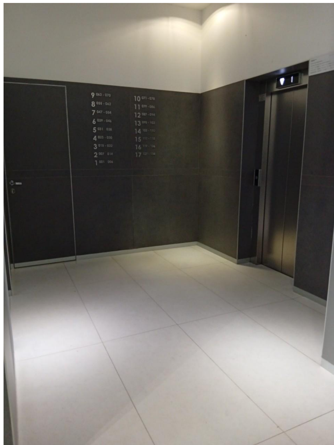
Фото 2. Ремонт первого этажа подъезда с использованием керамогранита (ул. Большевисткая, 102)
