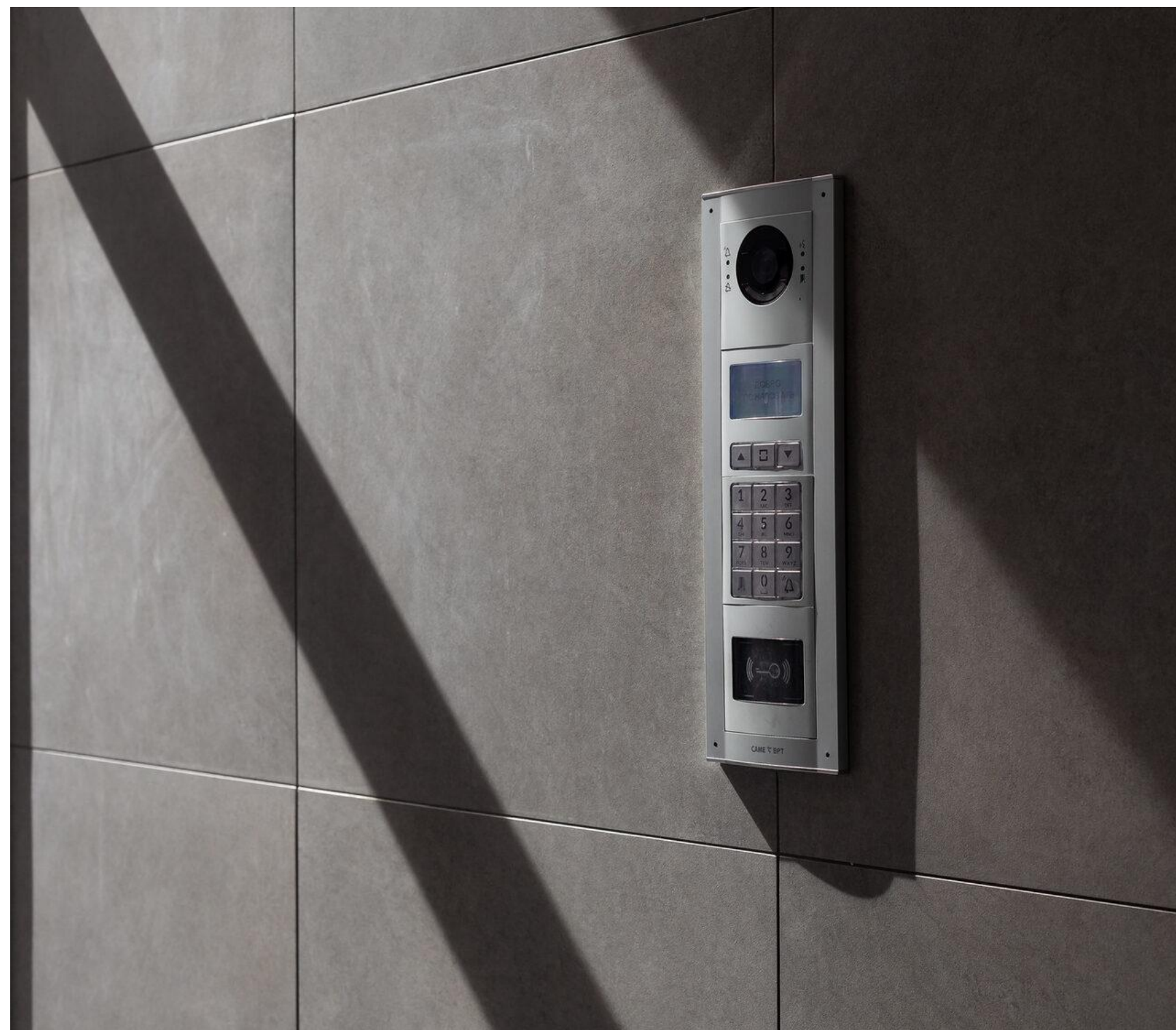
Фото 2. Пример облицовки входной группы кварцвиниловой плиткой
