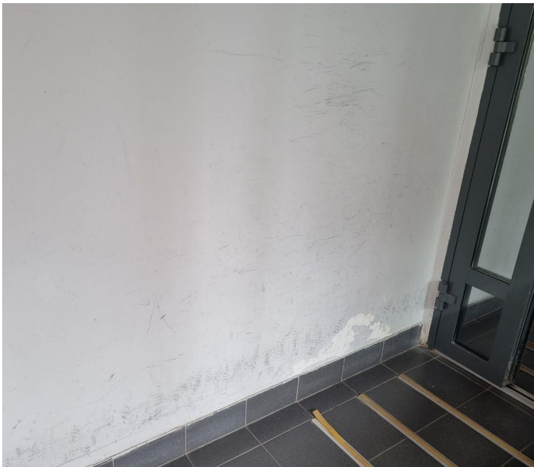
Фото 1. Исходное состояние входных групп
