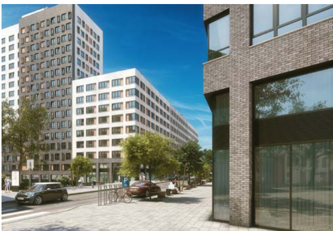
Торговые помещения, «Шишимская горка», Екатеринбург
