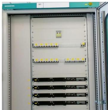
Внешний вид шкафа коммутаторов для шины процесса IEC 61850-9-2
