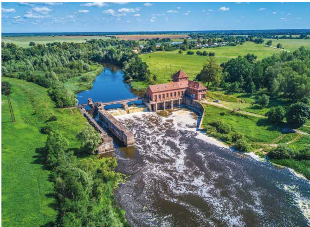
Правдинская ГЭС-4 на реке Лаве с высоты 50 м недалеко от пос. Курортного
