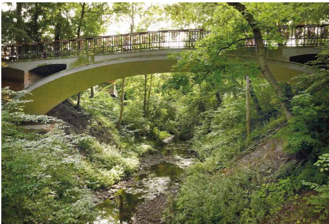
Вид на главный мост зоопарка из ущелья Паркового ручья
