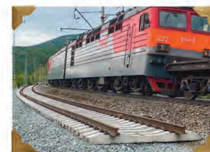
Строительство второго пути на участке Северобайкальск – Нижнеангарск
