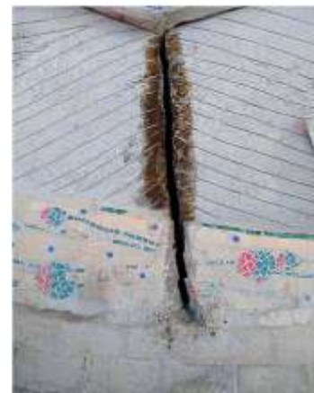
Подготовка основания, расчистка и обработка швов,
