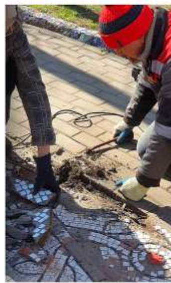
Подготовка основания, расчистка и обработка швов,
