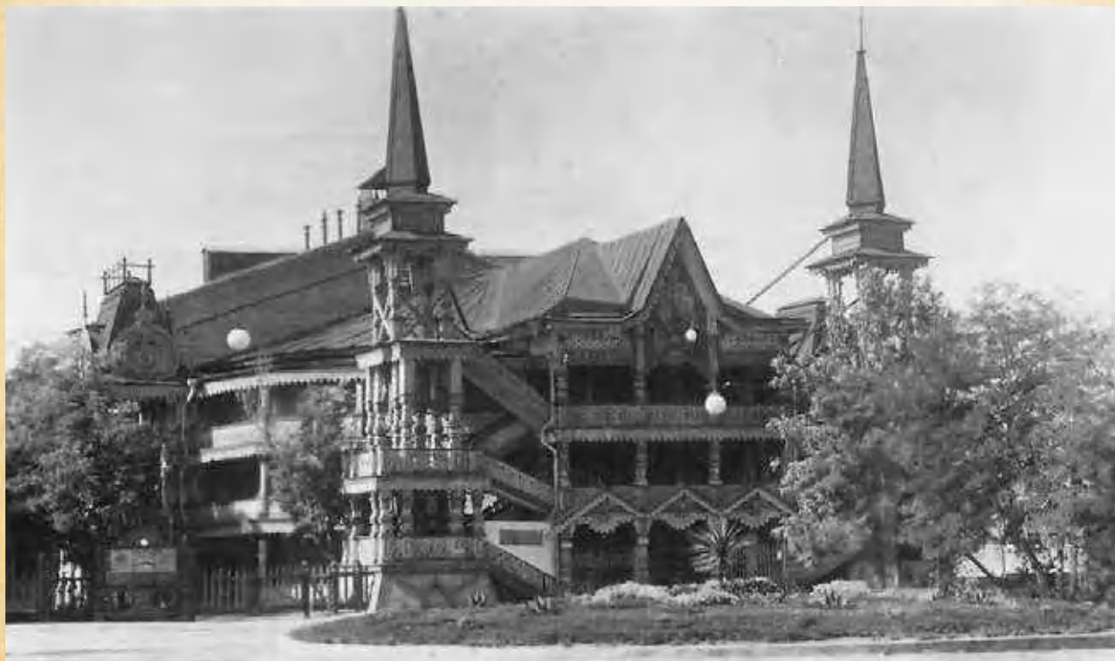
Здание театра, фото 50-х годов
