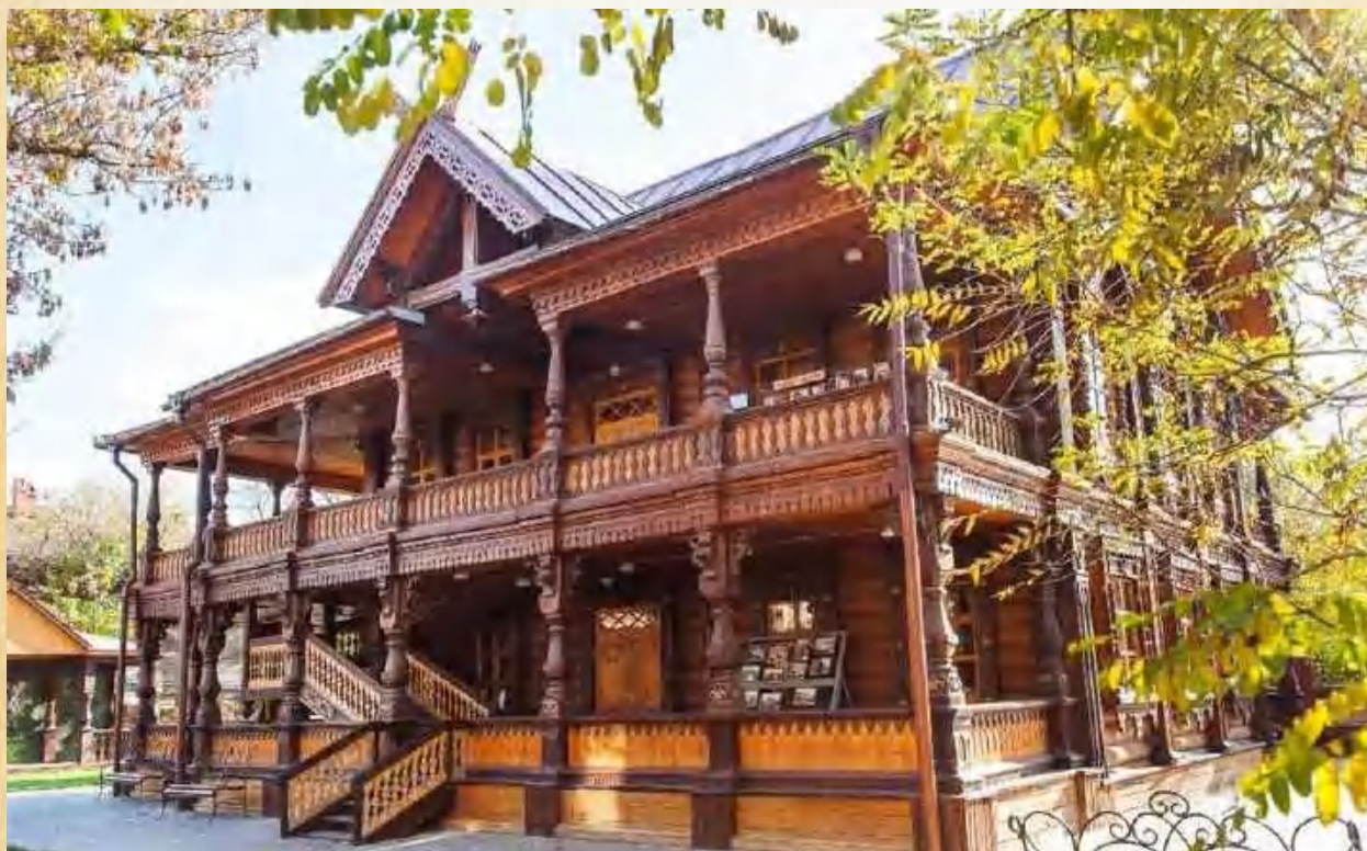
Дом купца Г.В. Тетюшинова до (начало 2000-х годов) и после реставрации (2010 год)
