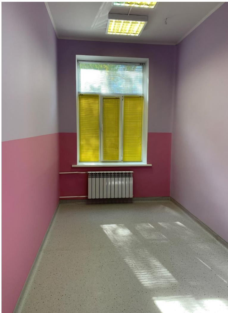
На фото: спальня изолятора Вышневолоцкого дома ребёнка «Солнышко» после ремонта с заменой радиаторов, светильников, пола и отделки стен.
