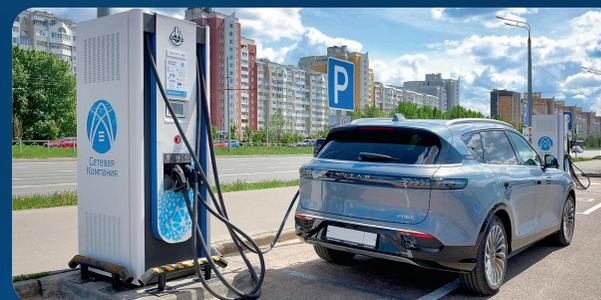
Быстрые зарядные станции имеют **3 типа коннекторов — GB/T, CCS2 и CHAdeMO** с возможностью динамической балансировки мощности при одновременной зарядке двух электромобилей
