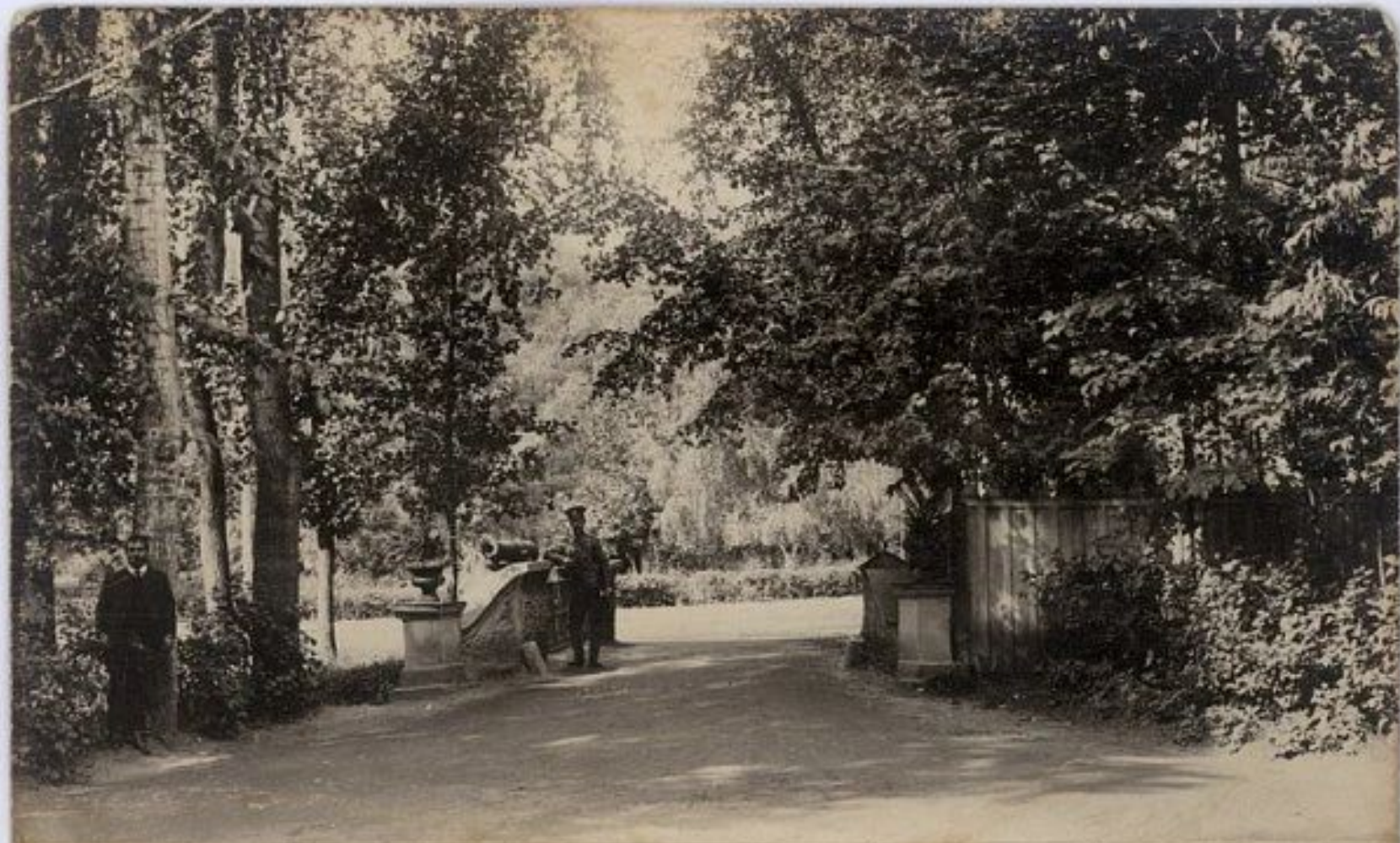
Каменный мостъ около ваннаго зданія въ г. Липецкѣ.
