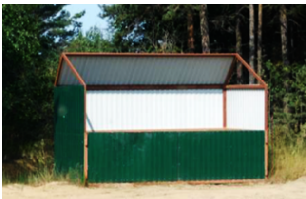
Рис. 9 – Вид на металлическую контейнерную площадку.
