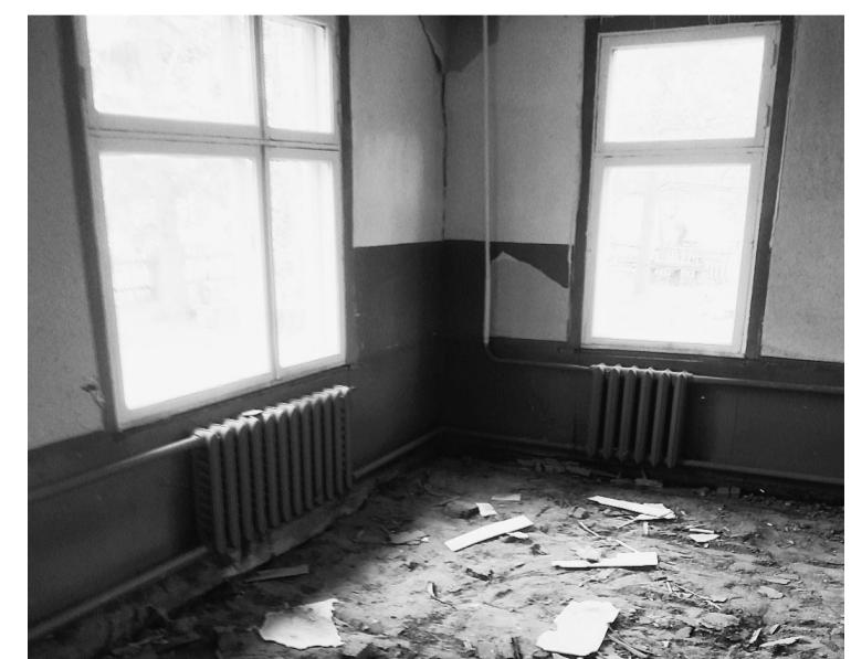
В помещении запланирована замена пола, окон, дверей, обустройство отдельного входа и строительство крыльца, замена электропроводки, косметический ремонт. На сегодняшний день произведены подготовительные работы – демонтаж полов и отделка стен. Планируемый срок выполнения контракта – 31 августа.
