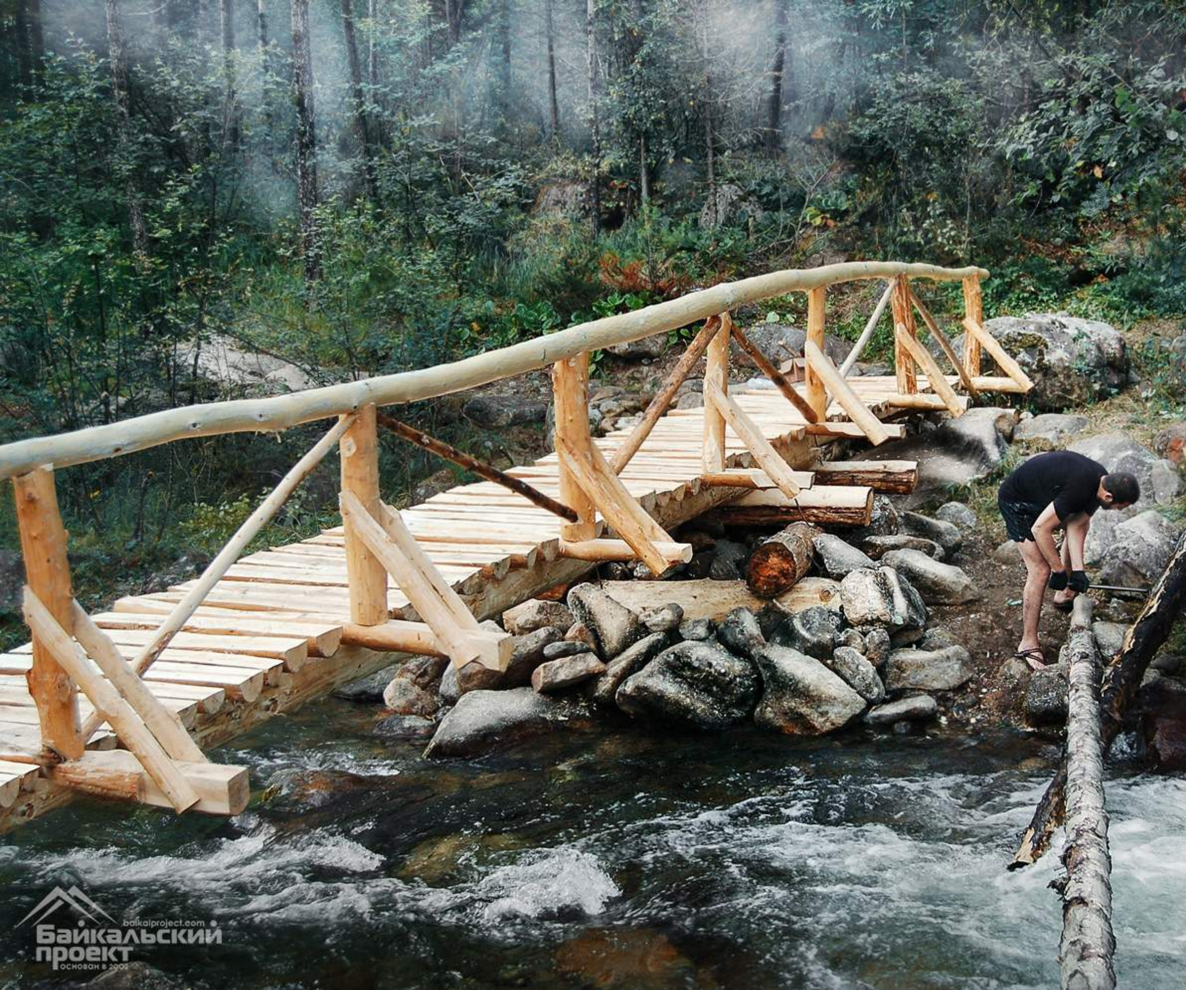
МОСТ «НОВОЕ НАЧАЛО» проектирование • строительство
