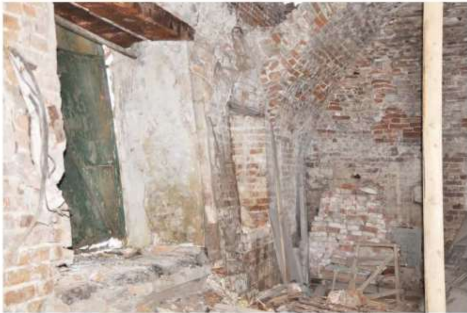
30. Поздний входной проём в западной стене.
