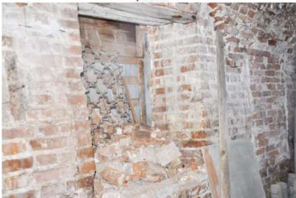
32. Растёсанный северный оконный проём западной стены.
