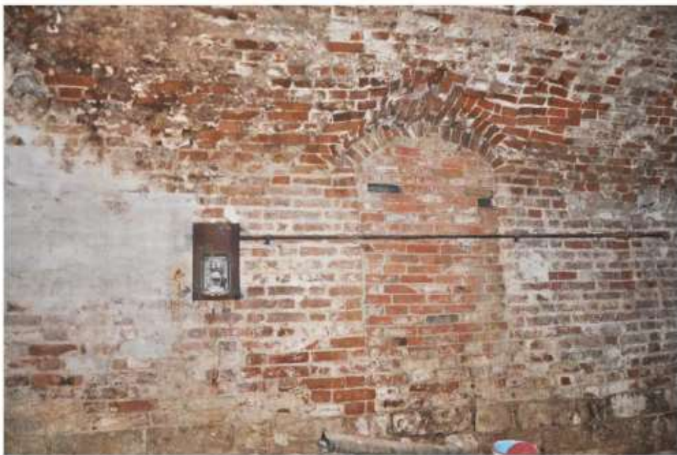
28. Заложенный южный оконный проём западной стены.
