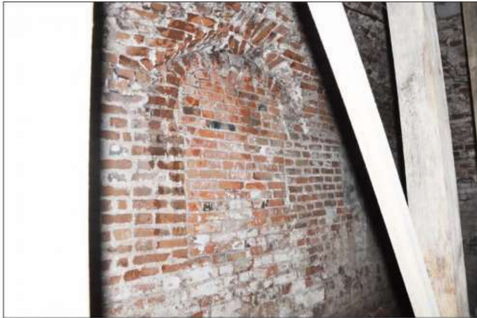
23. Заложенный северный оконный проём восточной стены.
