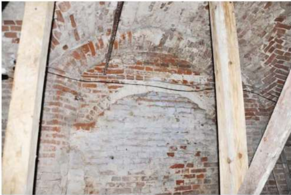
20. Заложенный первоначальный вход в северной стене.
