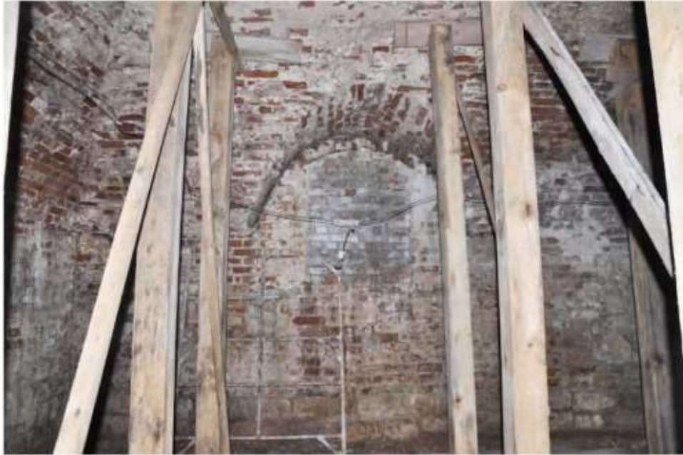
25. Заложенный восточный оконный проём южной стены.
