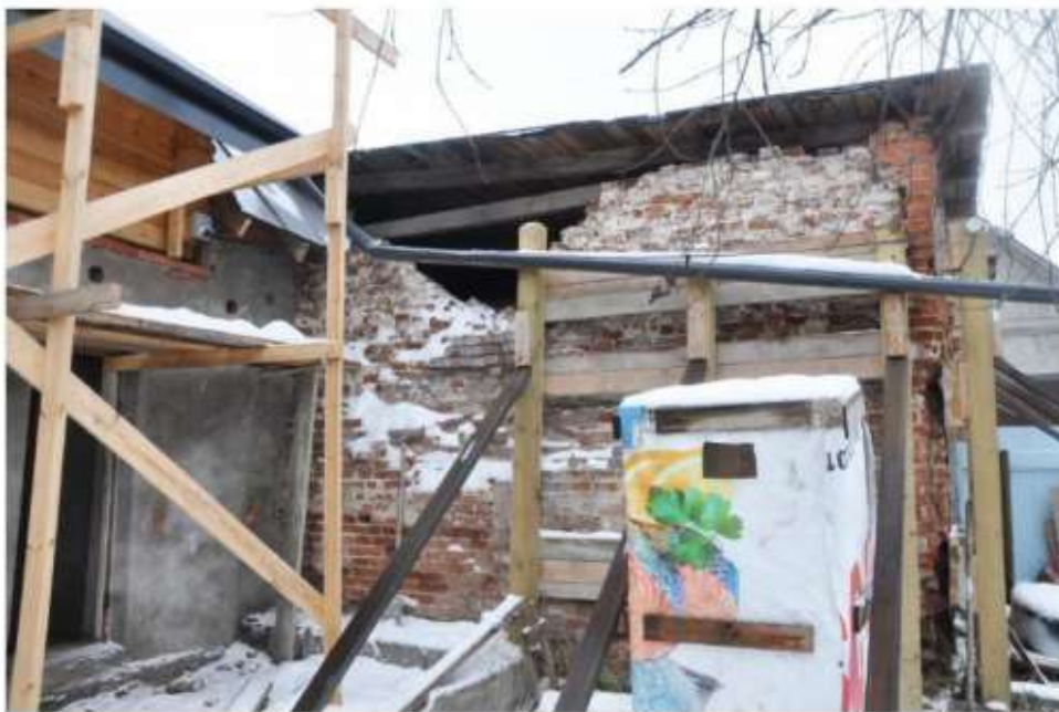
4. Северный фасад, западная часть.
