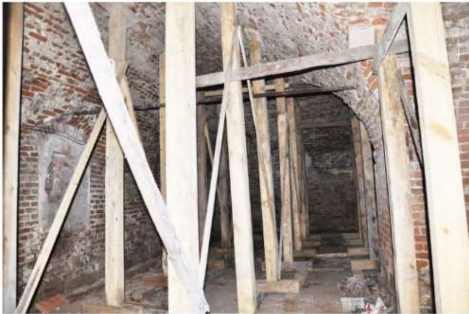
22. Вид по «восточному рукаву» с севера на юг.
