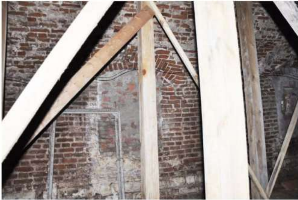
21. Заложенный восточный оконный проём северной стены.
