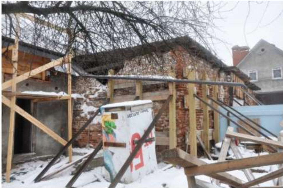
3. Вид с северо-запада.
