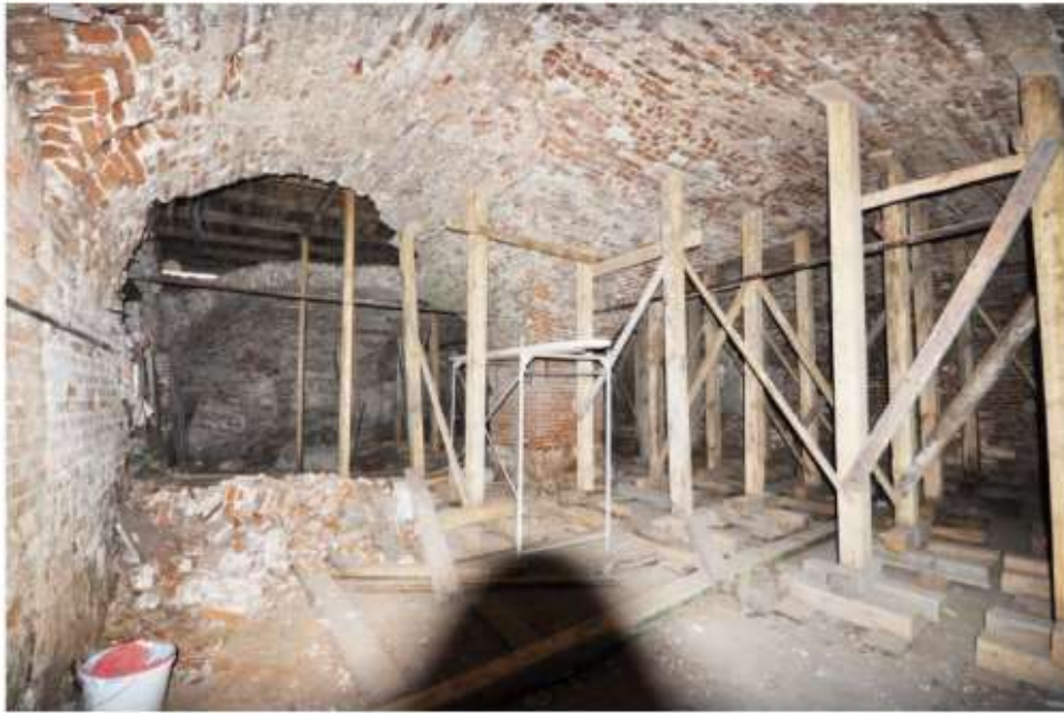
33. Общий вид помещения с юга.
