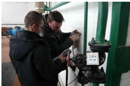
Обследование центральной котельной г.г. Ивня
