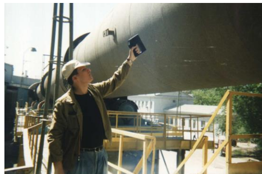
Обследование цементной вращающейся печи
