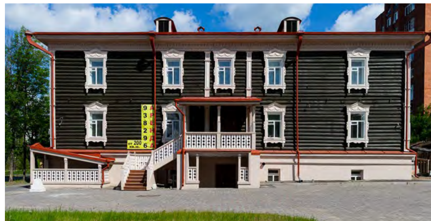
Реставрация исторического здания. Проспект Кирова 27, Томск
