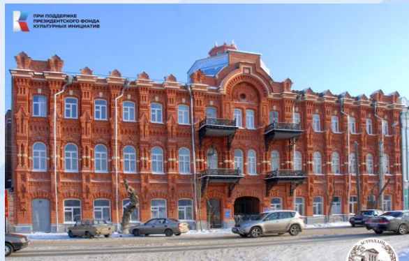
Дом И.П. Воробьева, г. Астрахань, ул. Адмиралтейская, 48
