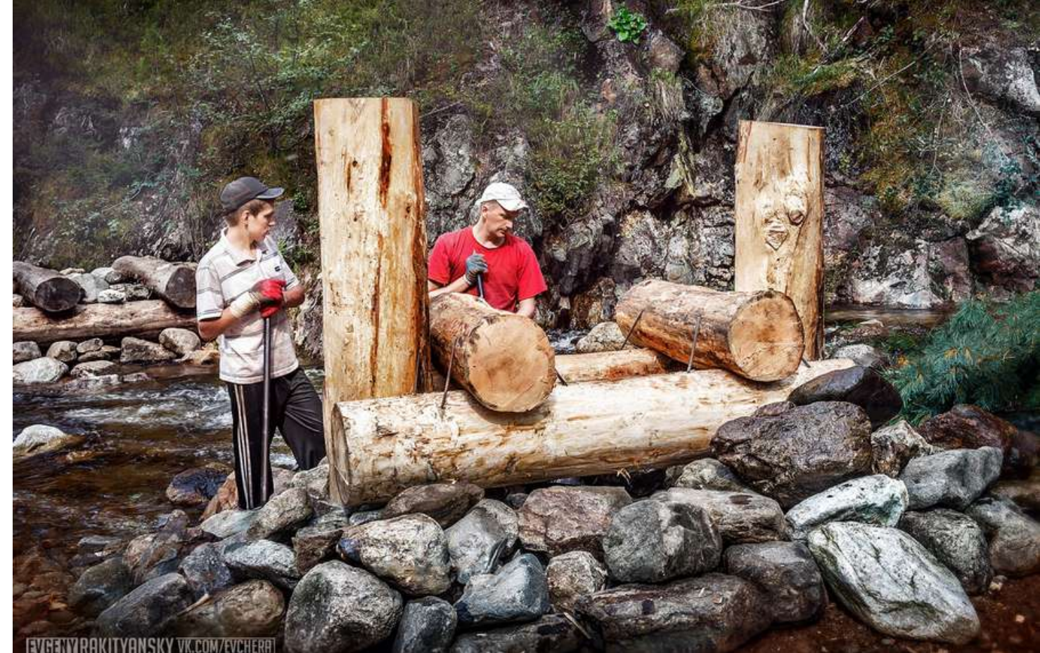
МОСТ «ЮБИЛЕЙНЫЙ - II» проектирование • строительство • дизайн
