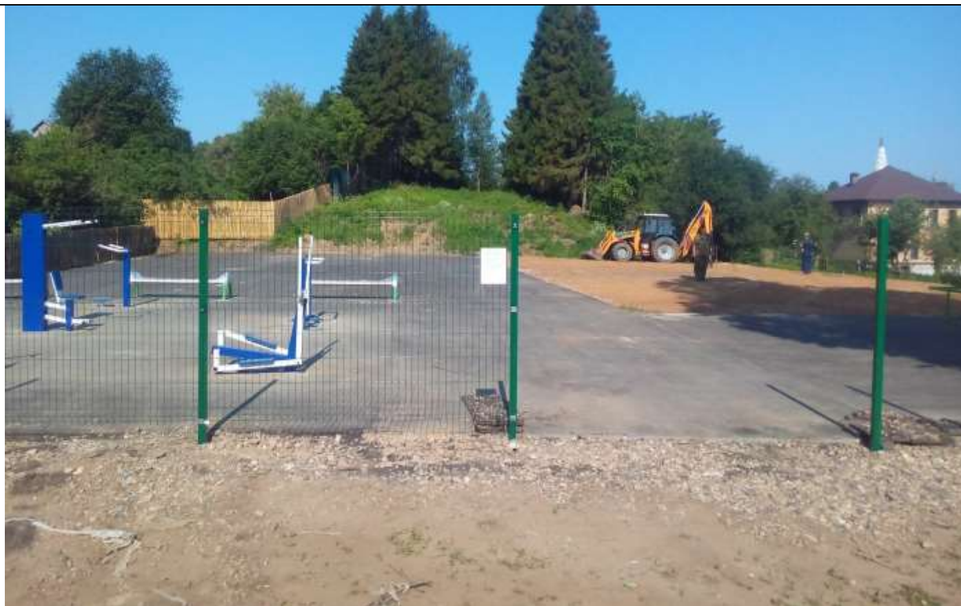
Установка ограждений (фото 9)
