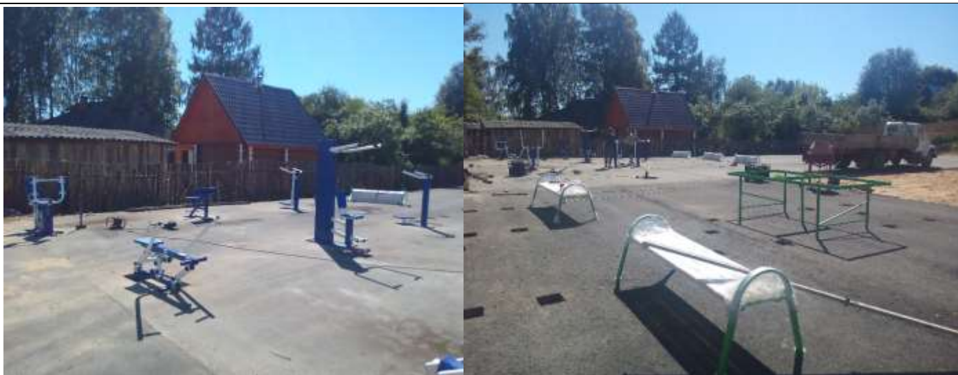
Установка спортивного оборудования (фото 6)
