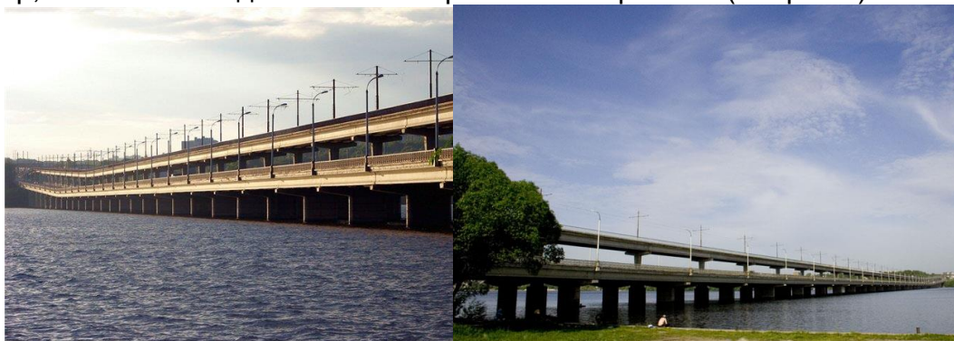
Рис.3. Мост "Северный" г. Воронеж
