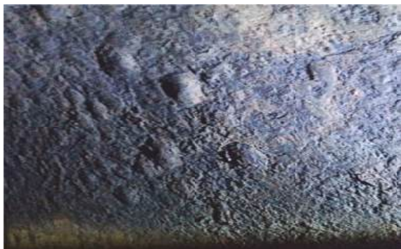
Рис. 7. Расслоение основного металла (блистеринг) корпуса нефтегазового сепаратора
