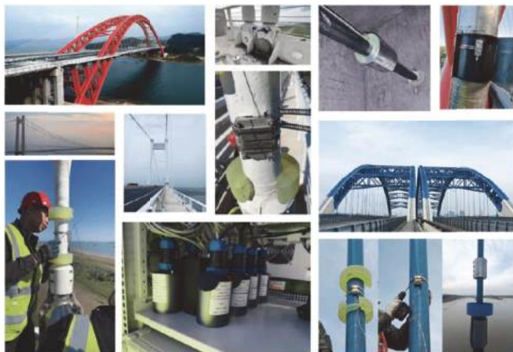
Рис. 4. Пример установки устройств контроля акустической эмиссии мостовых канатов
