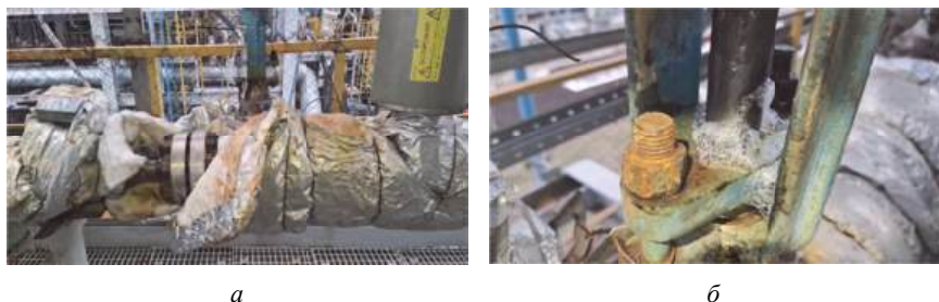
Рис. 8. Течь на уплотнителе запорного устройства а – общий вид, б – обмыливание течи
