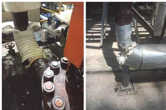
Рис. 7. Схема установки системы для контроля утечек
