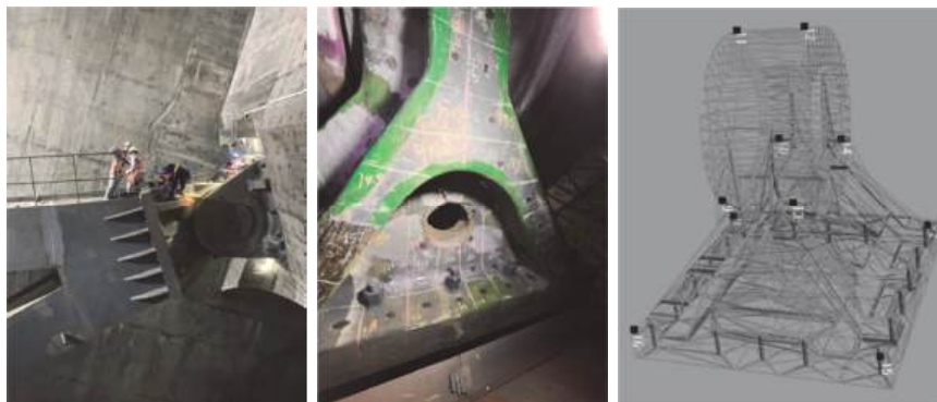
Рис. 8. Схема разделения сетки на шарнирно-подвижной опоре затвора
