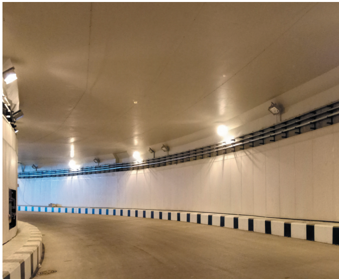
Московская область. Калужский разворотный тоннель. Три линии ЧЭ ИПТЛ «ЕЛАНЬ». Сколько бы здесь потребова- лось точечных тепловых извещателей?
