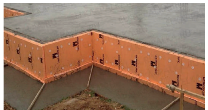
Монтаж пенополистирола
