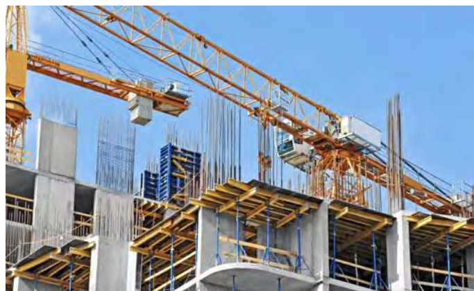
Монтаж опалубки
