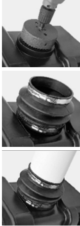
Рис. 8 Подсоединение вертикального подводящего трубопровода 110 мм (DN100)
