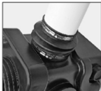
Рис. 9 Монтаж вентиляционного трубопровода
