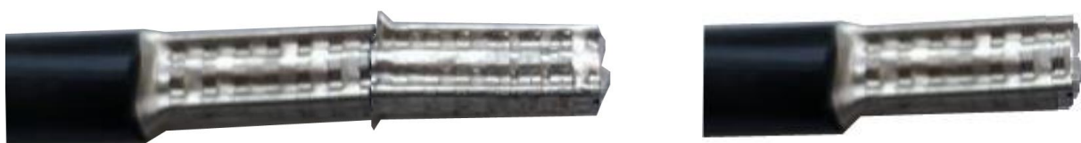
Рисунок 5.2 – Обжим провода СИП наконечниками НШВ для счетчика «Меркурий 238» (слева) и «Меркурий 208» (справа)
