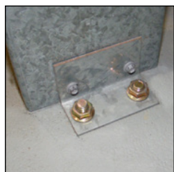
Крепление самонесущих конструкций.
