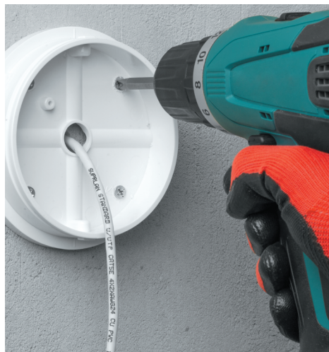
Крепление основания коробки к поверхности
