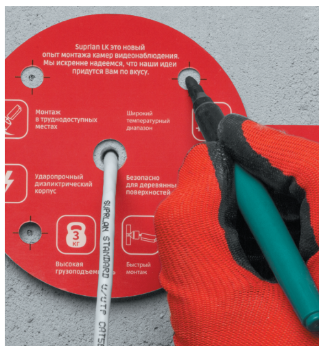
Разметка под крепёжные отверстия
