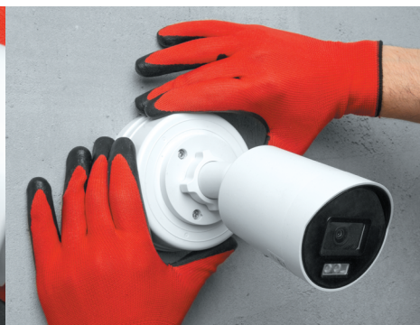
Зафиксируйте новую крышку с камерой на основании
