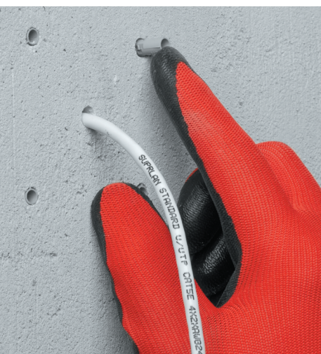
Сверление отверстий и установка дюбелей
