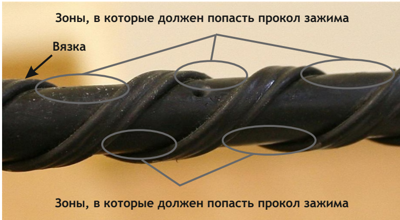
Рисунок 6 - Верное место расположения на проводе прокола зажима
