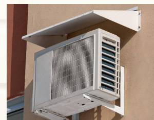
Крепление ОБОРУДОВАНИЯ на фасадах зданий
