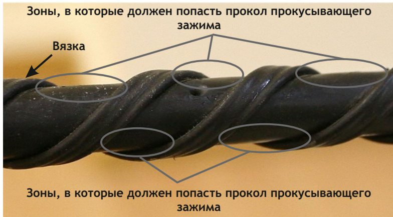
Рисунок 6 - Верное место расположения на проводе прокусывающего зажима
