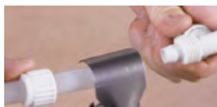
Монтаж пластиковых труб
