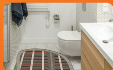
Электрического теплого пола
