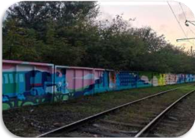
Станция Военное шоссе
