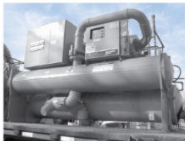
Рис. 30. Промышленная холодильная установка
