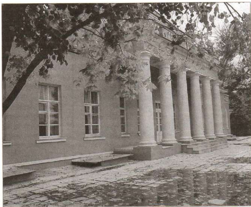
Овстуг. Фасад усадёбного дома
