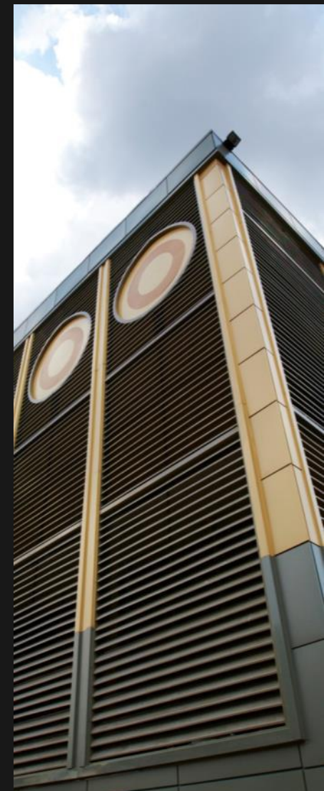
Строительство подстанции «Новая» 220/20 кВ
