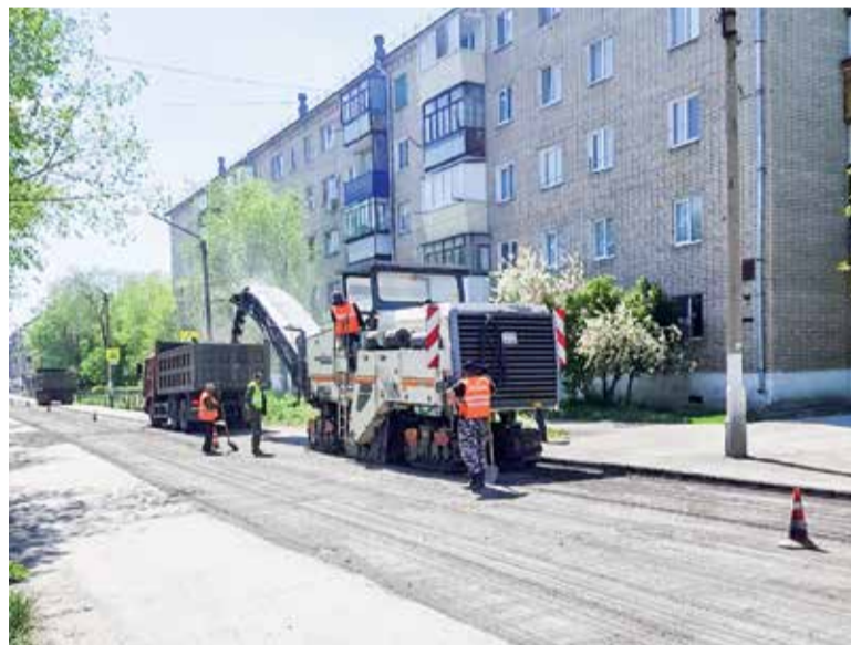
Ремонт дорожного полотна на улице Коммунистической
