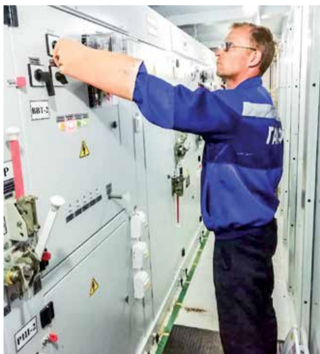
Обслуживание трансформаторной подстанции. Электромонтер О.Н. Ошурко
