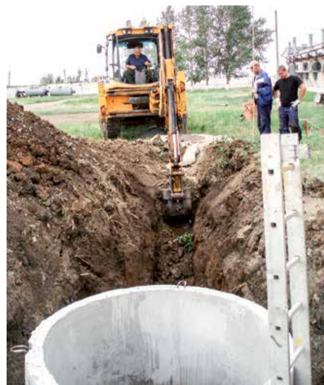
Ремонт колодца на территории предприятия
