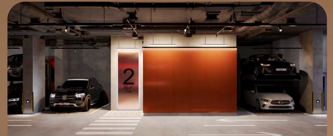
Подземный отапливаемый паркинг
