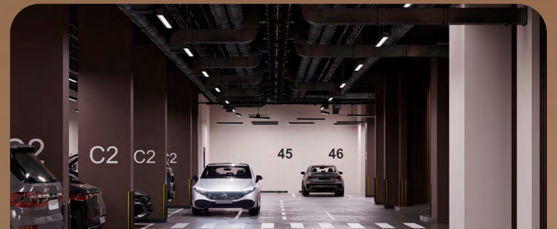
Трехуровневый подземный паркинг
