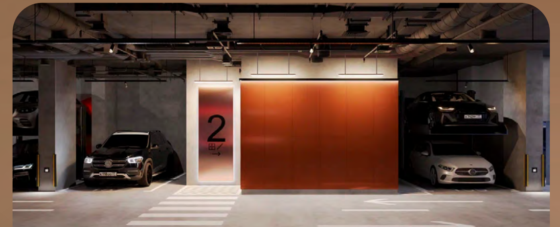
Подземный отапливаемый паркинг
