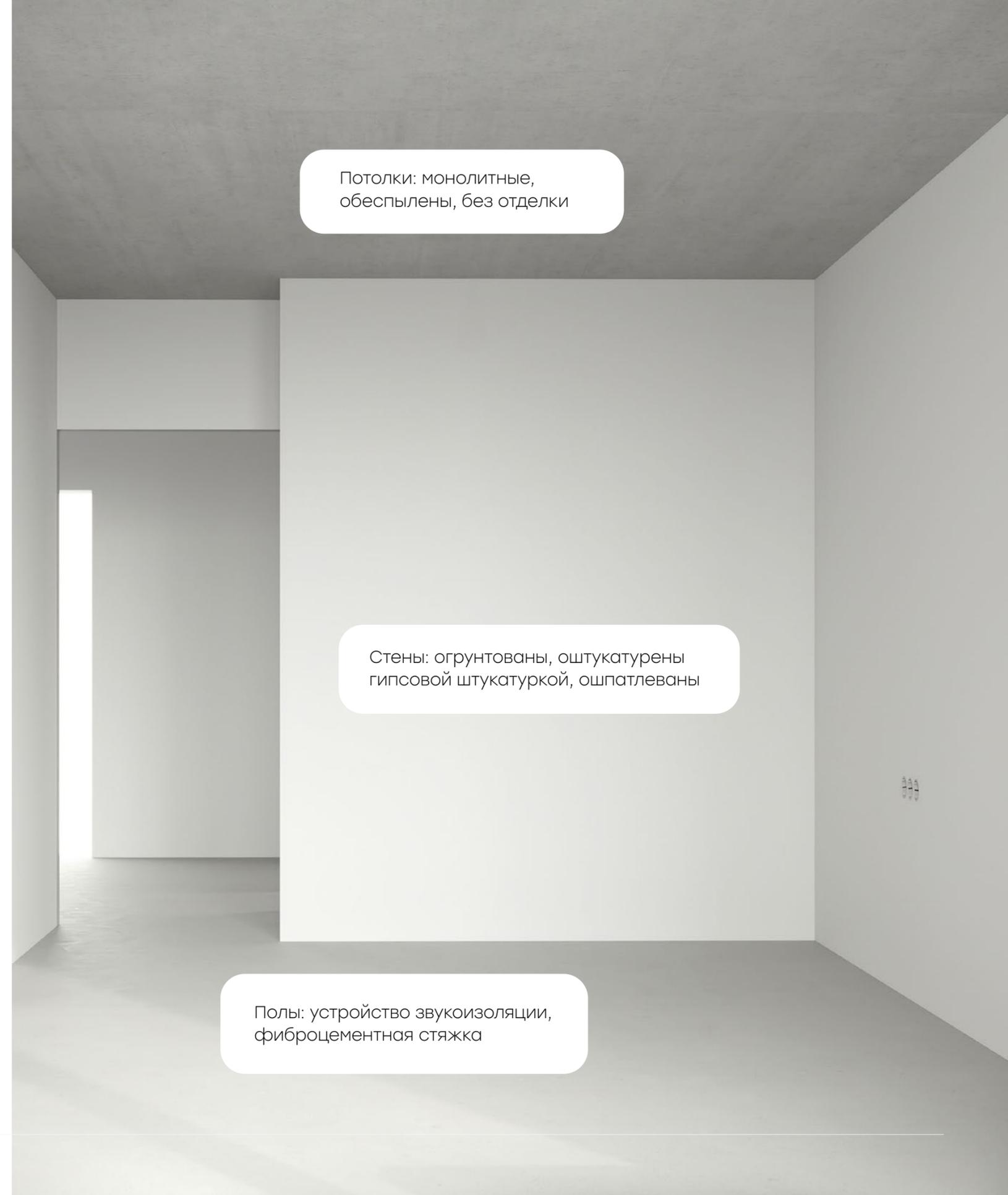
Потолки: монолитные, обеспылены, без отделки
